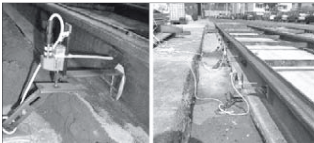
Abbildung 4: Prüfaufbau an der Schiene mit den montierten Wegaufnehmern
