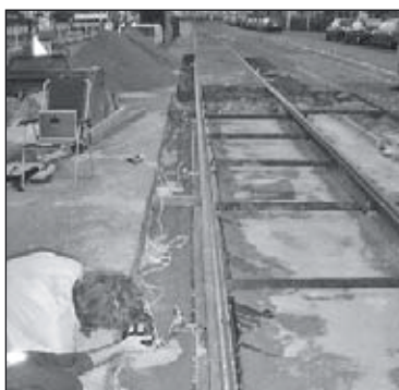
Abbildung 5: Untergrossener Gleisabschnitt, Einrichtung der Messapparatur
